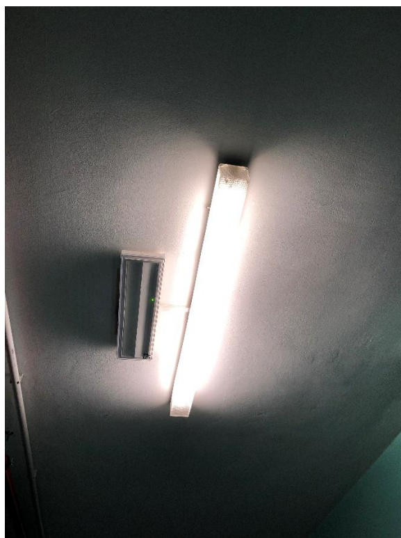
Figura 4 - Plafoniera neon a fluorescenza con 1 tubi da 1,20 m nel corridoio 5
