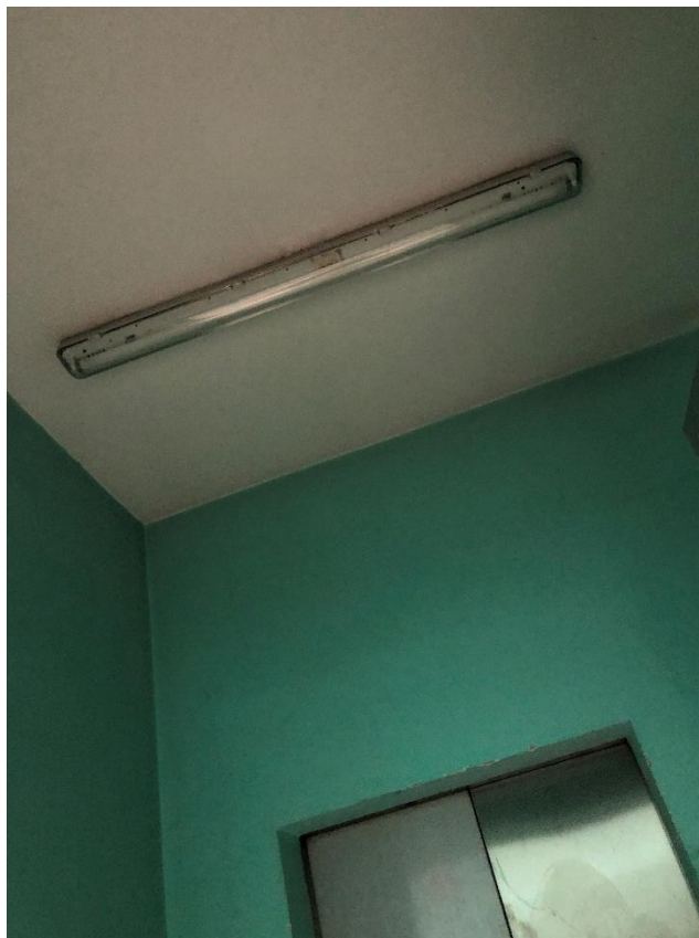
Figura 6 - Plafoniera neon a fluorescenza con 1 tubo da 1.20 m nel corridoio 12
