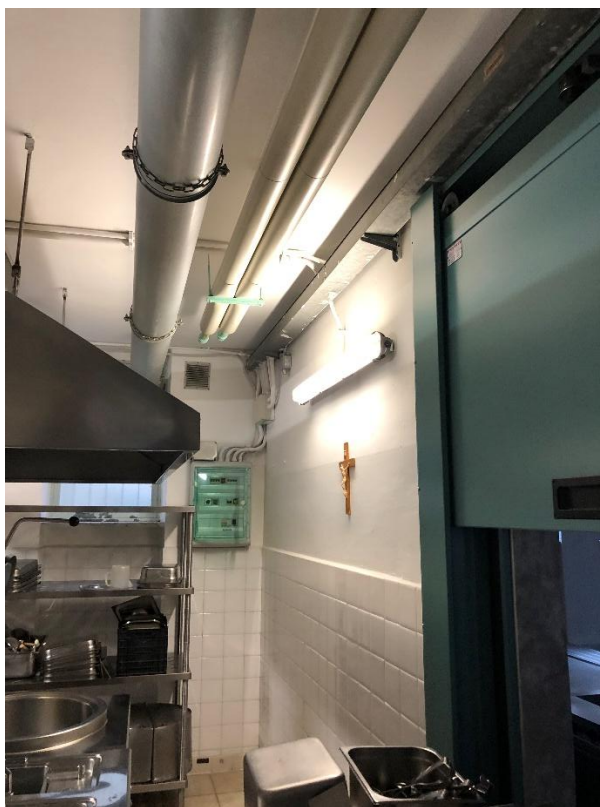
Figura 5 - Plafoniera neon a fluorescenza con 2 tubo da 1,50 m nella cucina
