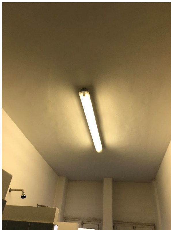
Figura 2 - Plafoniera neon a fluorescenza con 1 tubi da 1,20 m nella zona docce 2
