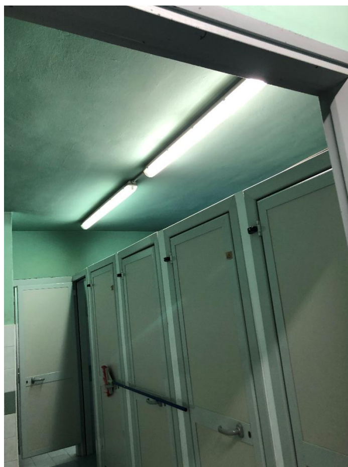
Figura 8 - Plafoniere neon a fluorescenza con 1 tubi da 1,20 m nei servizi igienici 1
